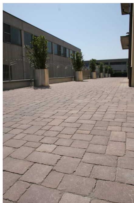
POSA ALLA ROMANICA
