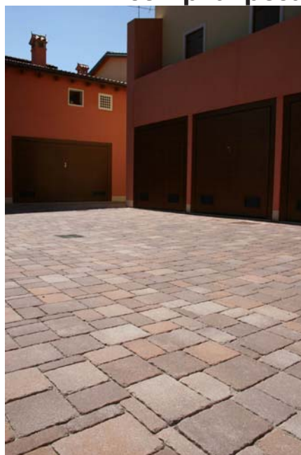
POSA ALLA ROMANICA
